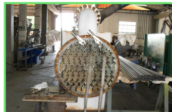
Ritubaggio di uno scambiatore
