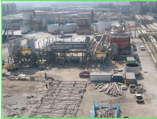
SOLVAY Rosignano Solvay Costruzione E Erezione Impianto Fenice
