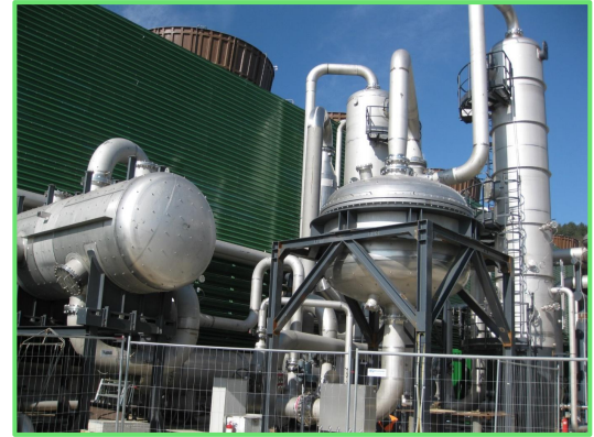
ENEL GREEN POWER, Bagnore Impianto AMIS; Costruzione E Montaggio Impianti Meccanici Ed Elettrici
